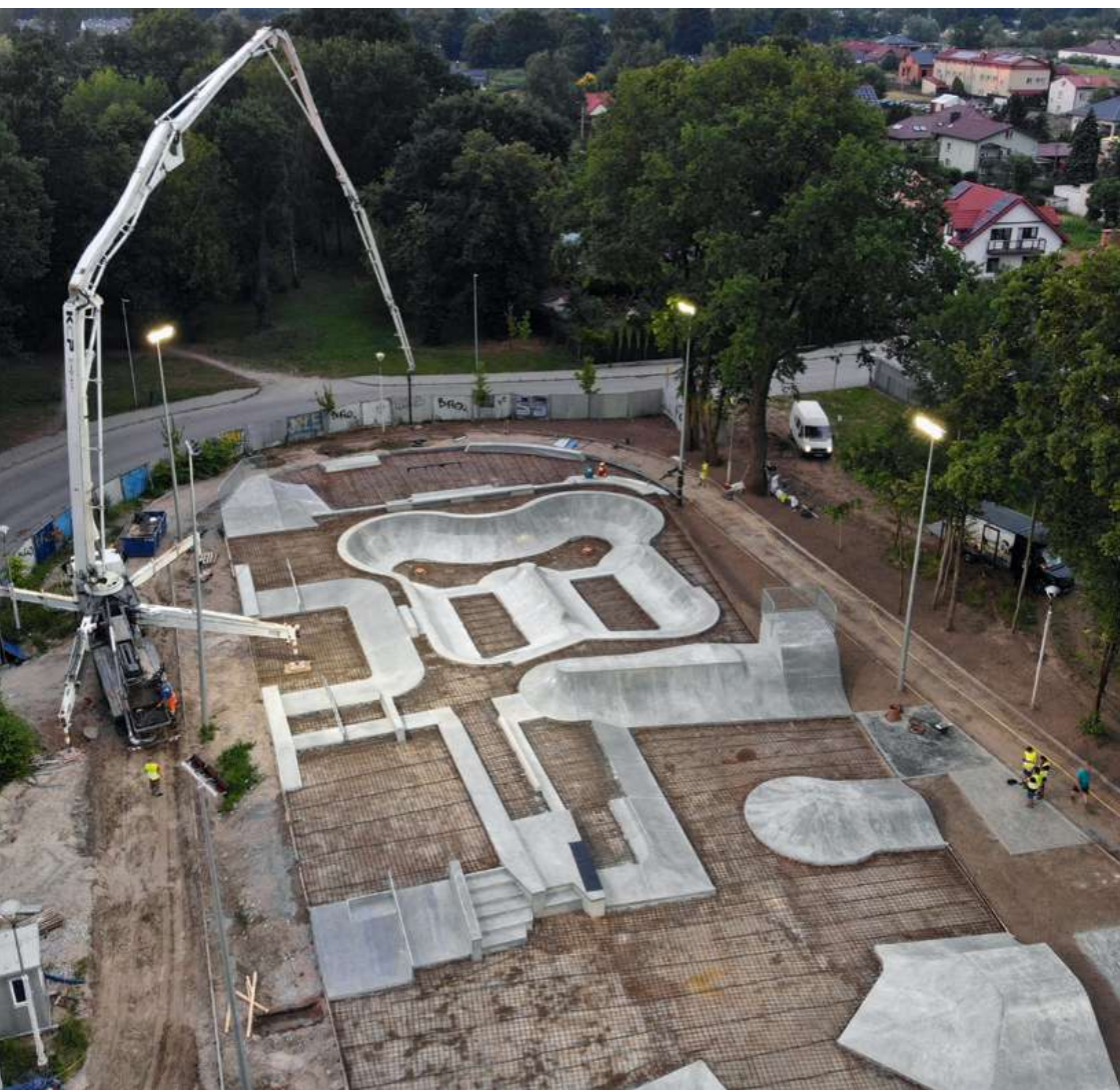
Fot.6.6.6 Torkretowanie betonu na budowie skateparku w Zielonce
