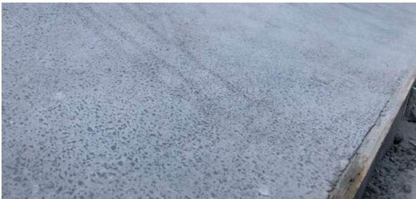
Fot.6.7.10 Brak zgodności barierki z normą (narożnik 90 °) oraz niedopuszczalne nierówności nawierzchni ze zburzonego skateparku w Tychach
