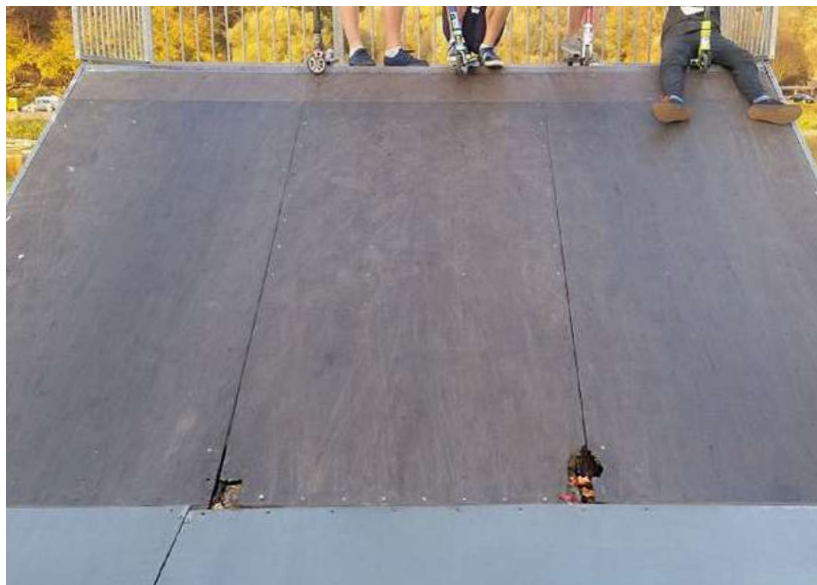
Fot. 7.7.4 Skatepark po 3-letnim użytkowaniu przy zastosowaniu na nawierzchni jezdnej sklejk obustronnie laminowanej zamiast płyt HPL w jasnym odcieniu
