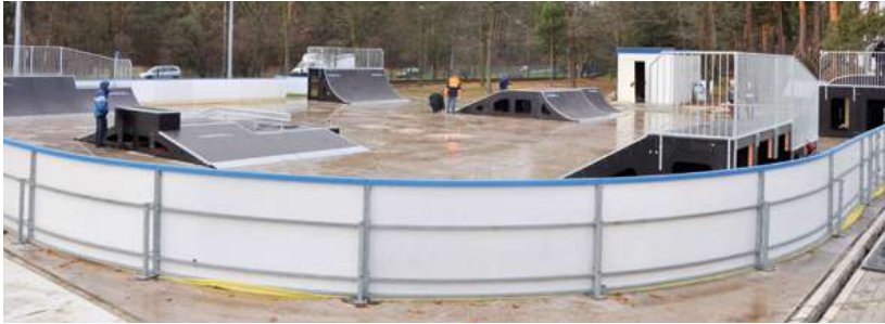
Fot.3.3.5 Skatepark zamontowany na lodowisku sezonowym w Kozienicach
