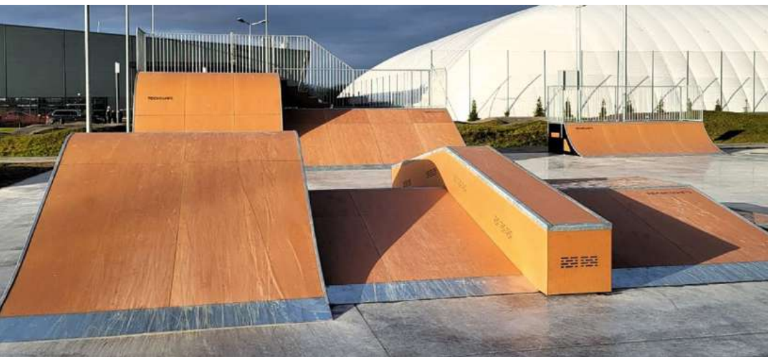
Fot.3.3.1 Przykład skateparku wykonanego z prefabrykowanych modułów drewnianych w Ożarowie Mazowieckim
