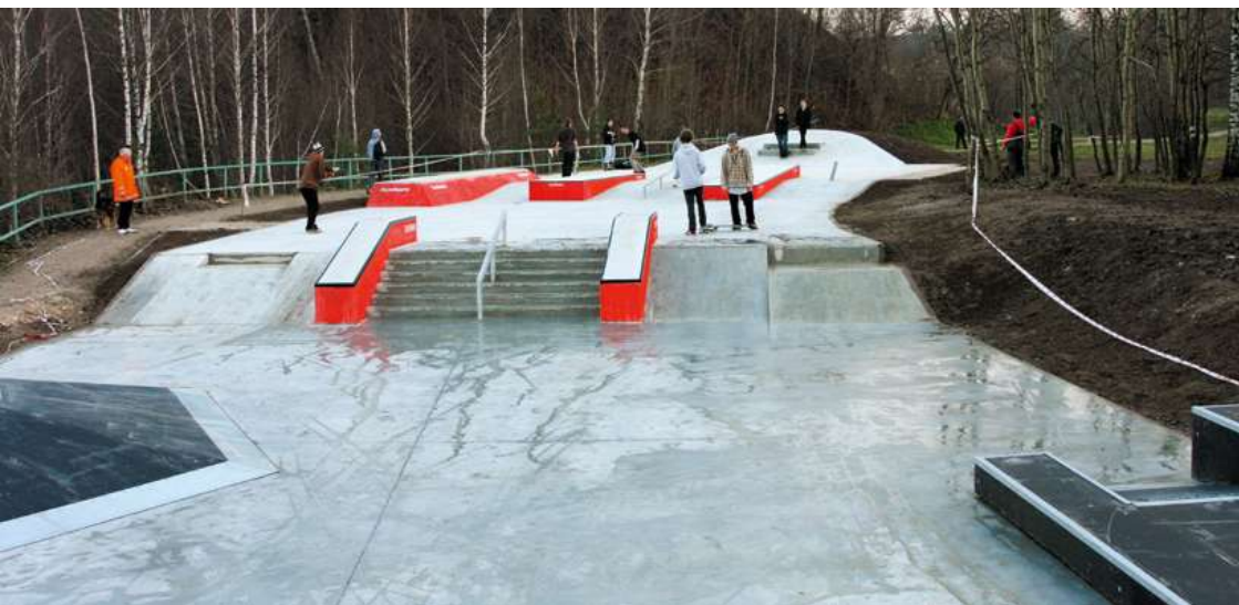
Fot.1.9.5 Skatepark betonowy w Radzionkowie
