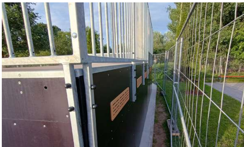
Fot.7.4.1 Ogrodzenie podczas montażu skateparku
