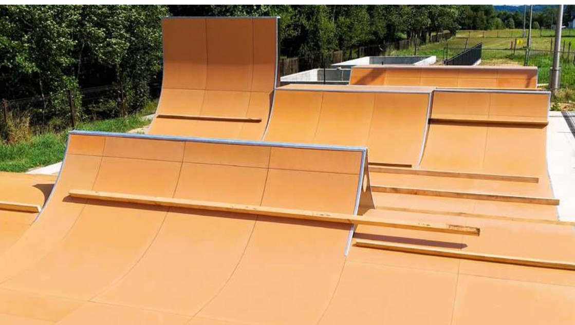
Fot. 7.5.1 Montaż skateparku modułowego
