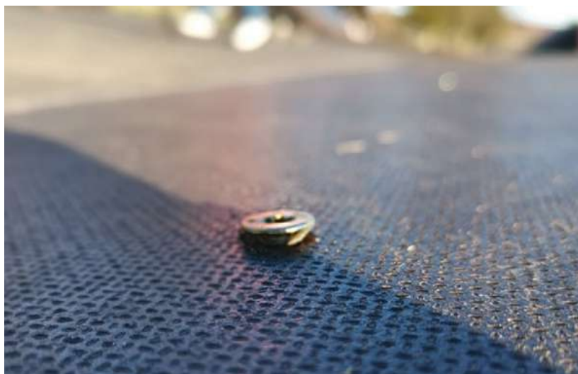
Fot. 7.7.2 Instalacja wkrętów
