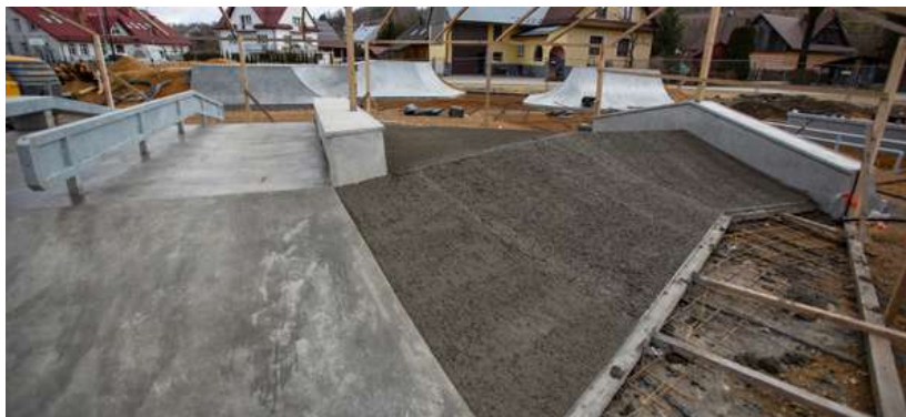
Fot.6.6.2 Budowa skateparku w Krakowie przy ul. Kąpielowej
