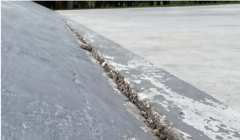
Fot.6.7.1 Klawiszowanie przeszkód
