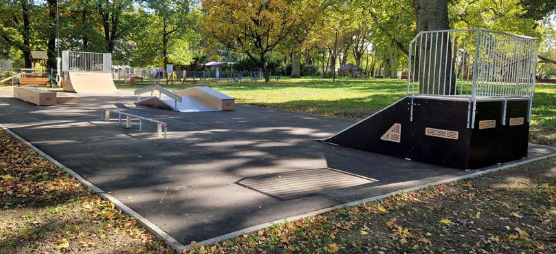
Fot. 7.2.2 Skatepark modułowy w Janczewie z nawierzchnią asfaltową
