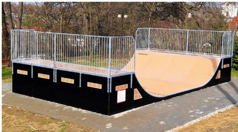
Fot.7.2.3 Minirampa modułowa w Żegocinach na nawierzchni z kostki brukowej
