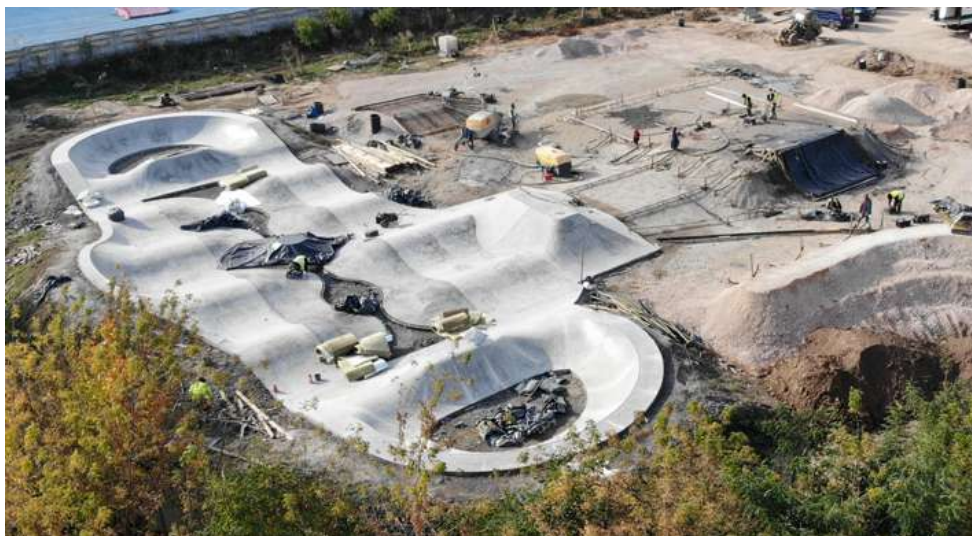
Fot.6.1.1 Prace nad skateparkiem w Mińsku Mazowieckim
