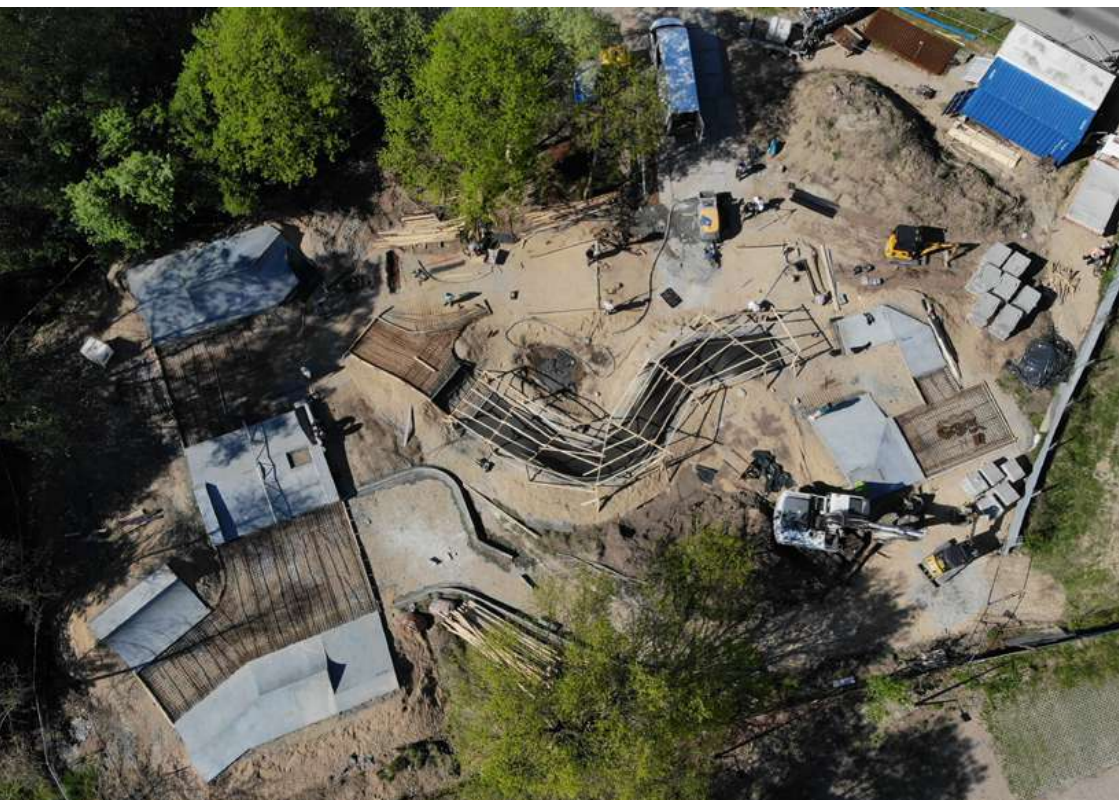
Fot.6.6.4 Zbrojenia na budowie skateparku w Bystrej Podhalańskiej
