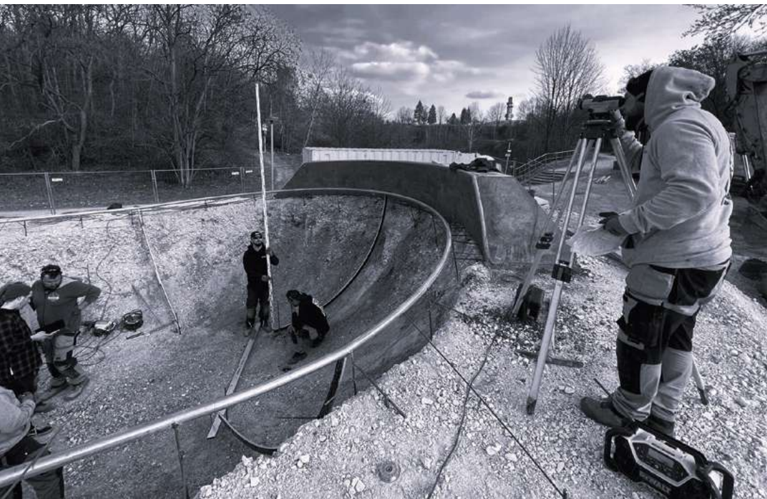
Fot.6.2.1 Kontrola budowy
